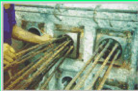
Colocação das placas de ancoragens para protensão
