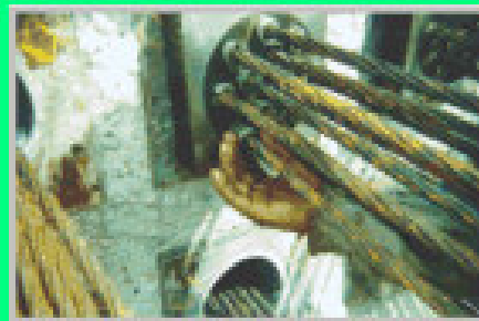
Colocação das cunhas para protensão
