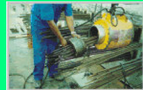
Montagem do macaco para protensão
